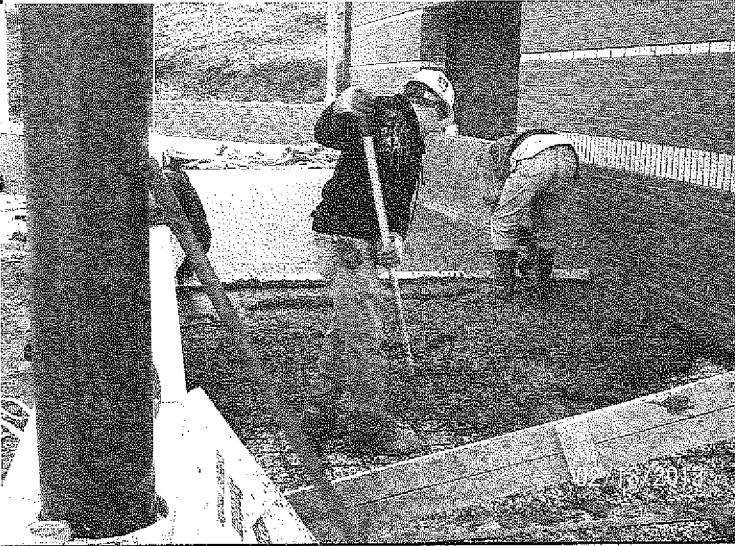
#1--Concrete pour in front of the Press Box.
